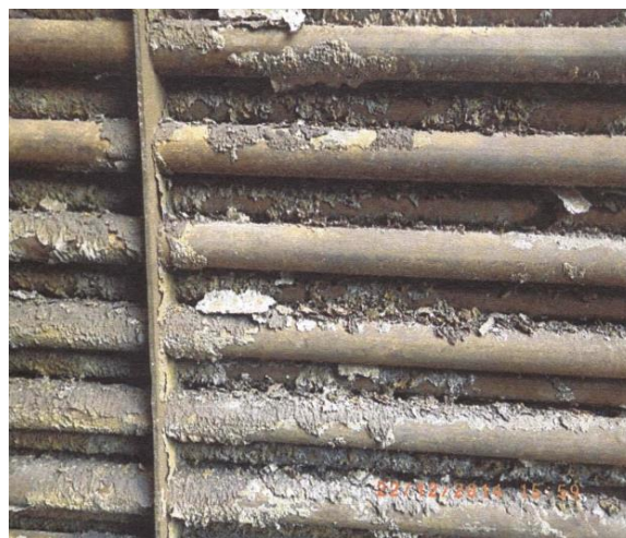
Рисунок 2 - Средняя часть низкотемпературной секции теплообменника для нагрева воздуха
