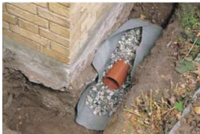
Рисунок 1.6 – Прокладання дренажних труб ( https://pp-budpostach.com.ua/ )
