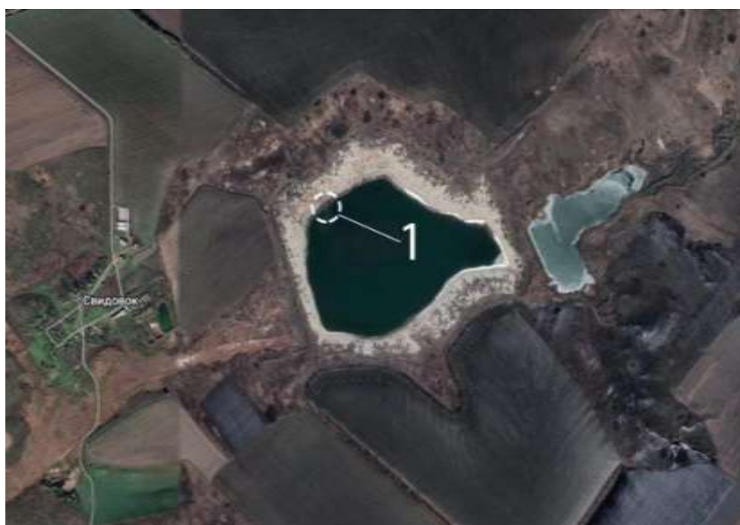
Рисунок 4.60 – Балка Свидовок: 1 – накопичувач шахтних вод (Google Image, 2025)
