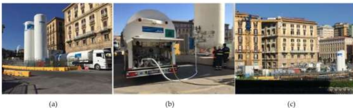
Рисунок 2.7 – Обладнання для заморожування підземних вод: a – автотранспорт для перевезення рідкого азоту; b – завантаження рідкого азоту з автотранспорту в спеціальну цистерну; c – загальний вигляд промислового майданчика [82]
