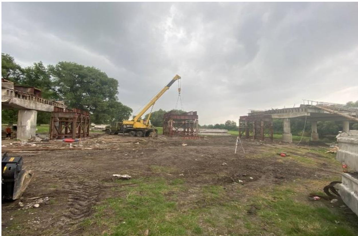
Рисунок 3.14 – Встановлення надбудов опор за допомогою стрілового крану
