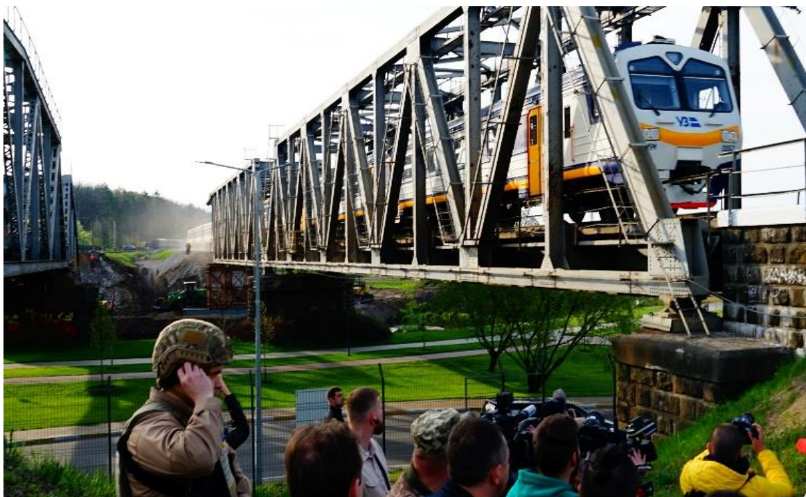
Рисунок 3.19 – Відкриття залізничного руху по відновленому мосту
