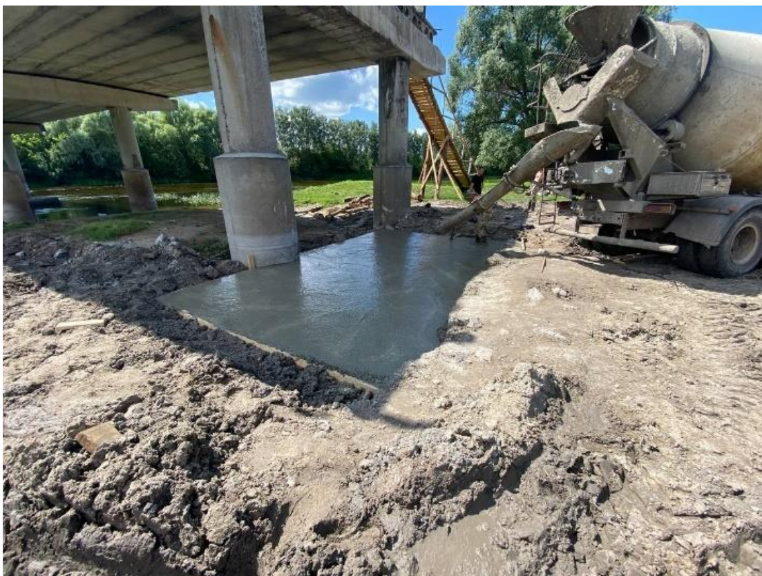
Рисунок 3.13 – Улаштування монолітного залізобетонного ростверку
