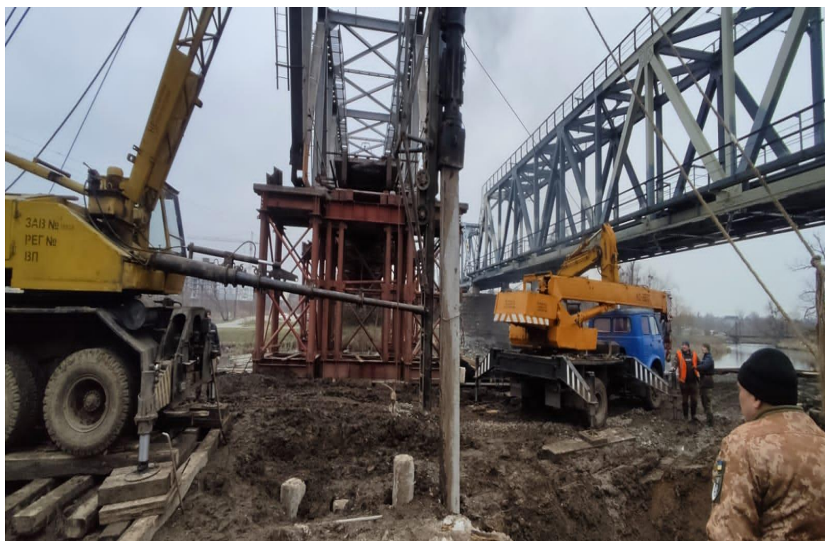
Рисунок 3.17 – Влаштування додаткового пальового фундаменту
