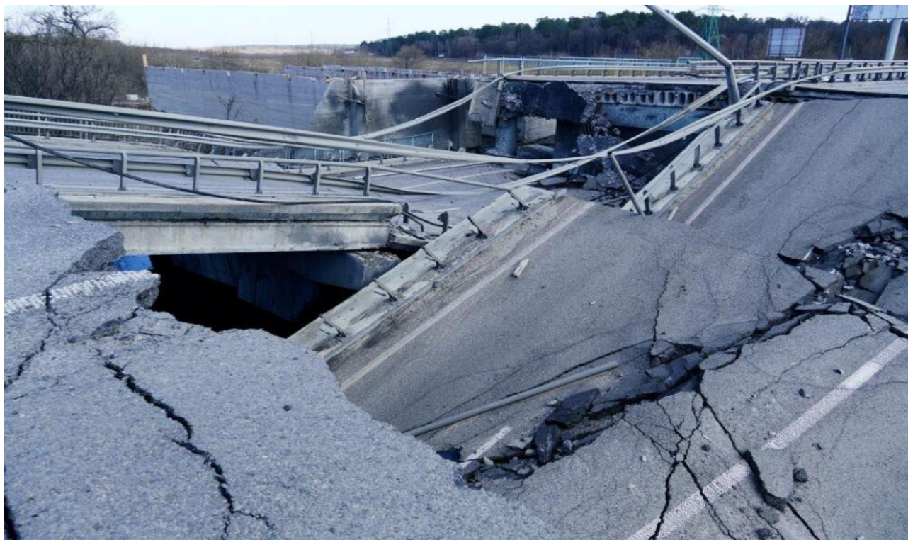
Рисунок 3.4 – Руйнування мостів: автомобільний міст через р. Ірпінь в районі н.п. Стоянка. Підірвані плити прогонових споруд та проміжні опори
