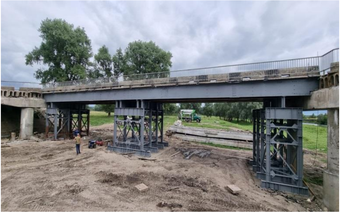
Рисунок 3.15 – Загальний вид відновленого мостового переходу
