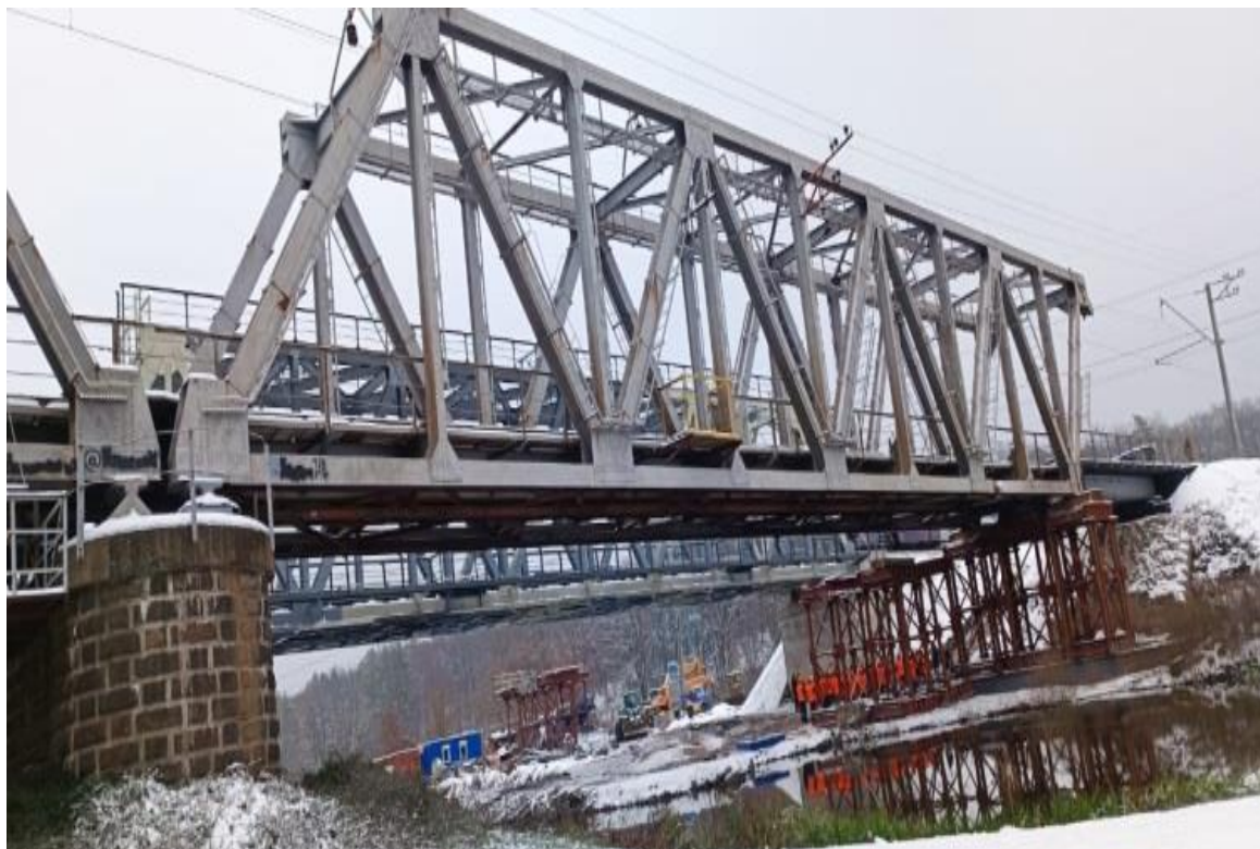
Рисунок 3.18 – Відновлення залізничного мосту за тимчасовою схемою
